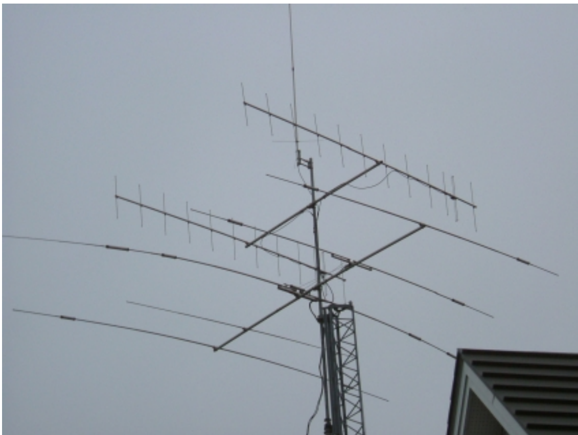
(筆者の家のアンテナ 下が7,14,21,28 のトライバンダー4エレメント八木、その上の魚の骨のようなのが12エレメント八木スタック、そして一番上にあるのが無指向性のグランドプレーンアンテナ)
